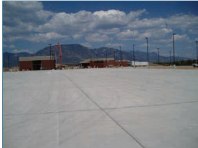
Şekil 7-12. Kesilmiş enlem ve boylam derzler
