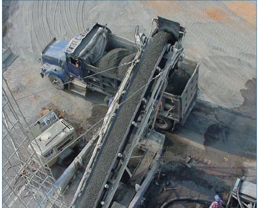
Şekil 7-2. SSB'nin homojen olarak kamyonlara yüklenmesi (California ve PCA)
