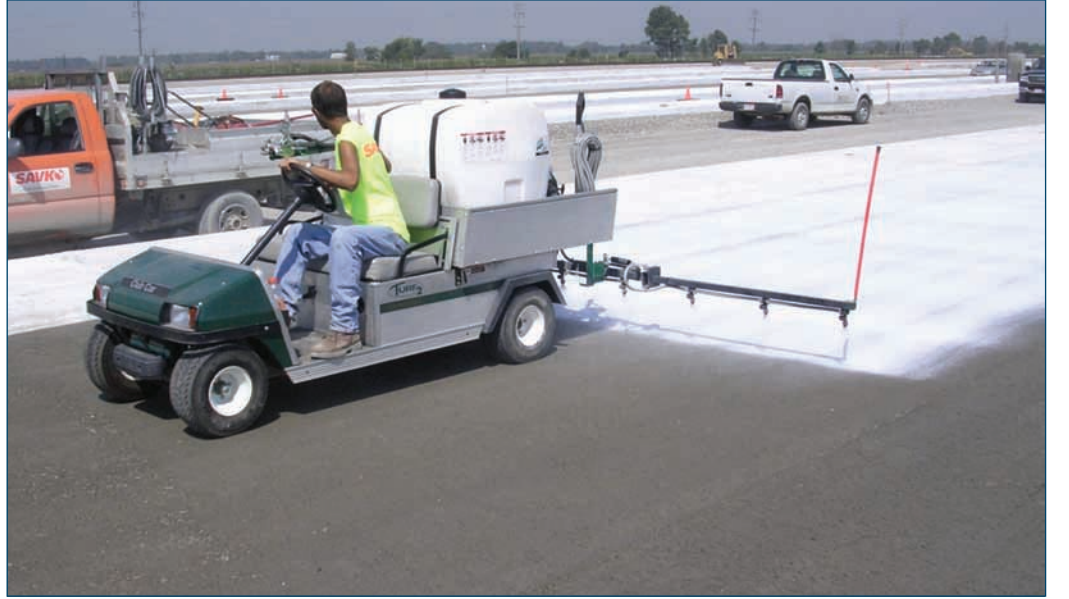
Şekil 7-16. Kür malzemesinin uygulanması
