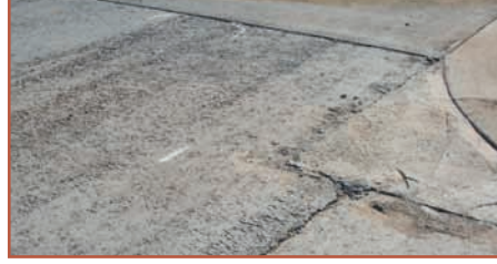
Karışım serme ve sıkıştırma sırasında dağılma eğilimi göstermesi
