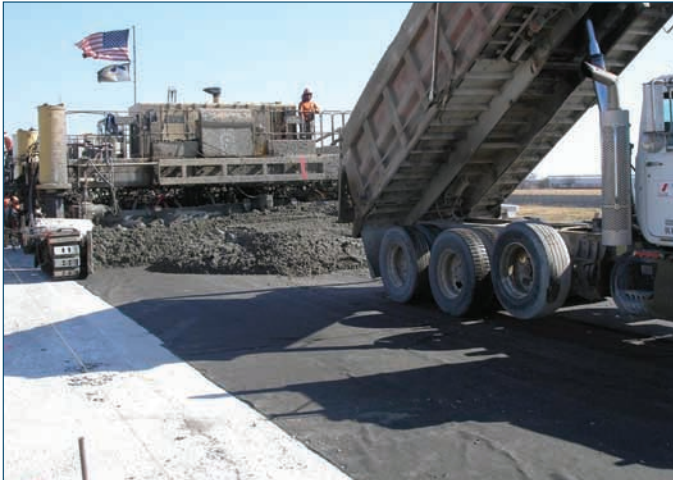
Şekil 2-7. Geotekstil fabrika tabakasında beton serimi
