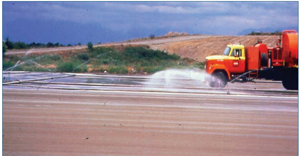
Şekil 7-17. Nem kür işlemi. Sulama ve püskürtme ile kür uygulaması
