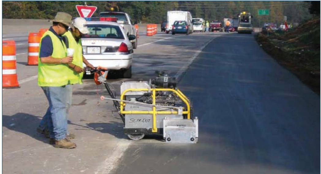
Şekil 7-13. Yol kenarı enlem derzin kesilmesi
