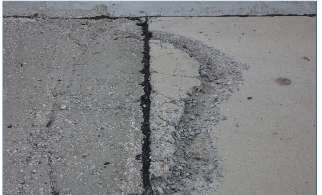
Şekil 5-7. SSB plaklarında genleşmeye bağlı olarak oluşmuş bozulmalar
