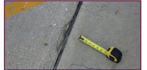
Soğuk derzde parçalanma ve uflanma
