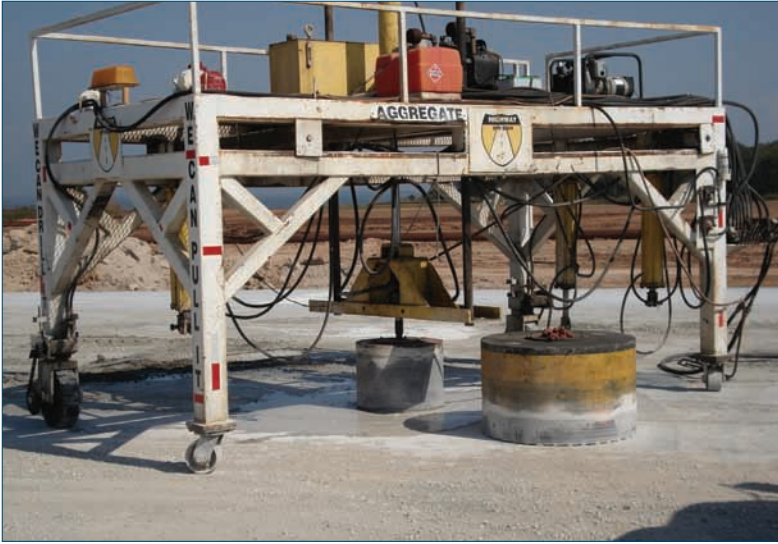
Şekil 7-15. Karot alımı (sol) kanalizasyon kapağı etrafında izolasyon derzi (sağ)
