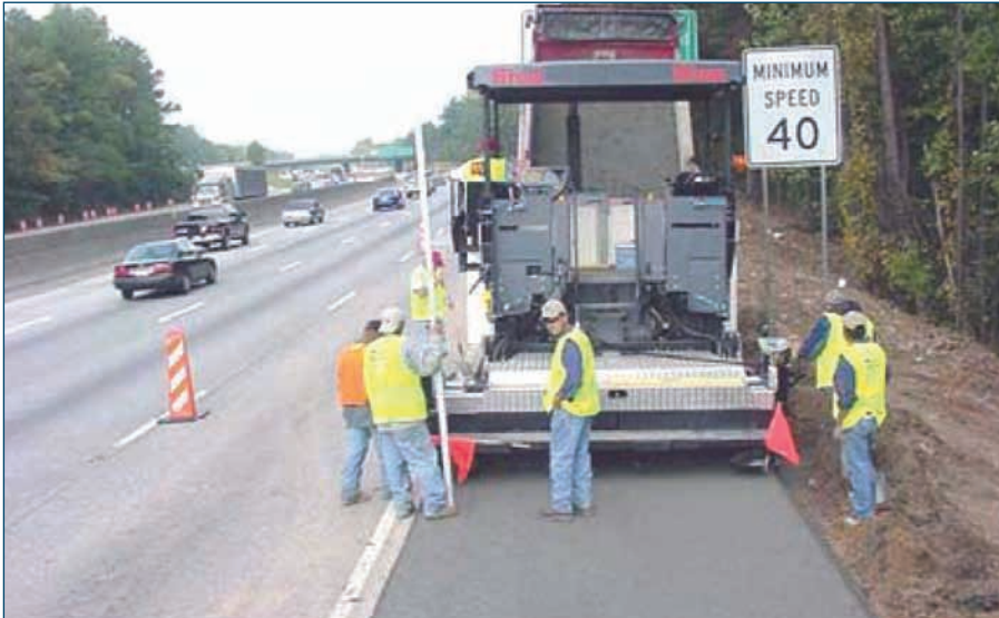
řekil 2-6. Atlanta, GA yakınlarında I-285 yolu üzerinde kaldırımların yeniden inřasında SSB kullanımı
