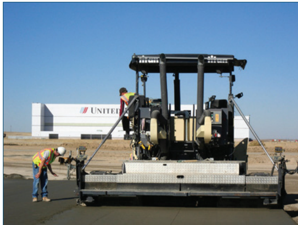
Şekil 2-3. Havaalanında SSB yol serim uygulaması
