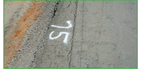
İstenen yoğunluk elde edilmemiş
