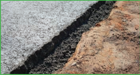
Kenar çökmeleri/kenarda zayıf sıkıştırma
