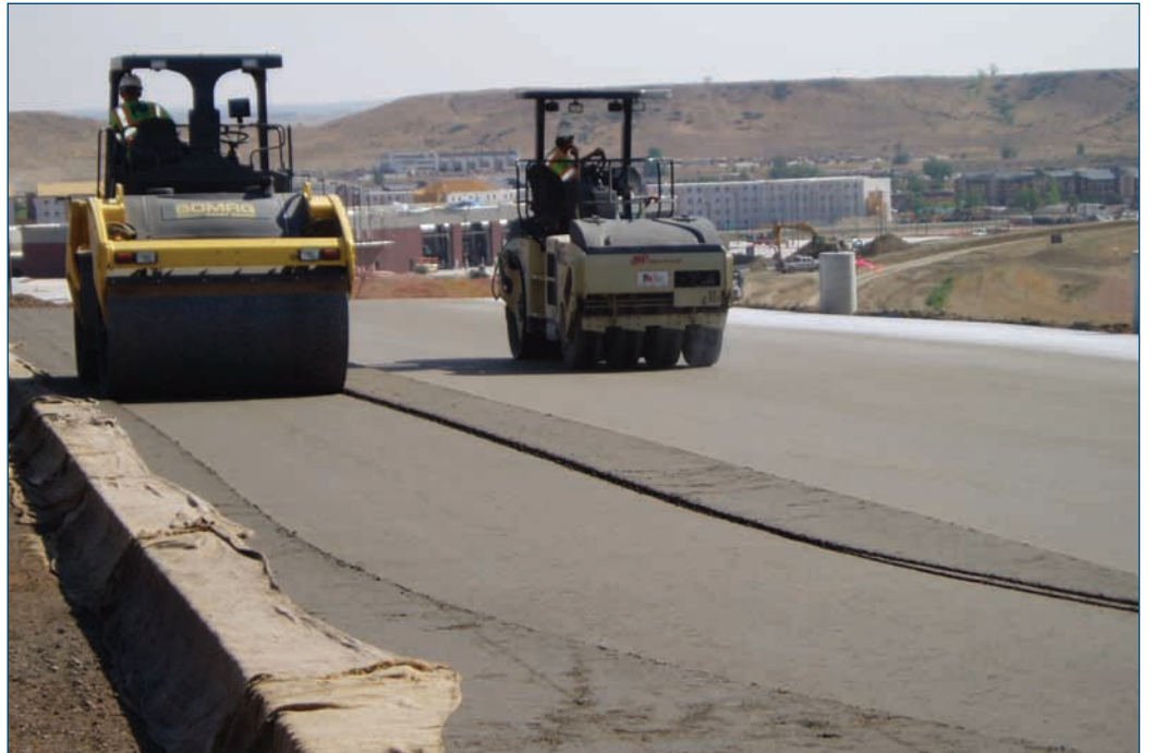
Şekil 7-5. Pnömatik (tekerlek) ve çelik silindir sıkıştırma makinelerin yan yana görüntüleri (Edwards)
