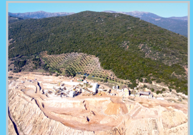
Cihatlı Agregat Tesisi
