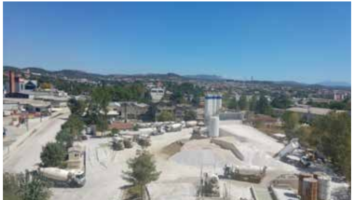
4. Mevcut Geçit hazır beton tesisi içerisinde 2. beton santrali kurulması
