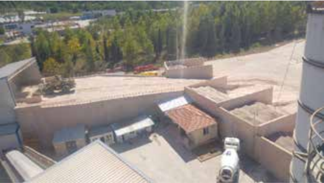
1. Yeni Kestel hazır beton tesisi kurulması
