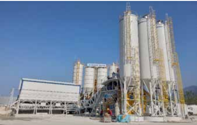
3. Mevcut Gemlik hazır beton tesisi içerisinde 2. beton santrali kurulması
