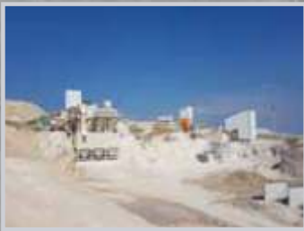
Yeşilçömlü Agregat Tesisi
