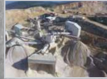
Kayapa Agregat Tesisi
